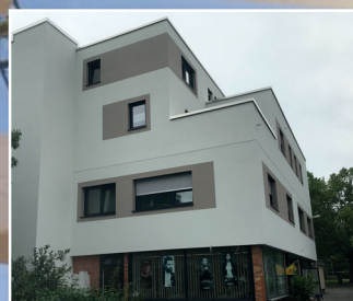
Aufstockung Wohn- und Geschäftshaus
