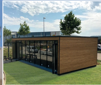
Pavillon in Modulbauweise
