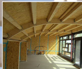
Architektenentwurf für Modegeschäft komplett in Holz gebaut
