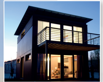
Gebäude in Modulbauweise
